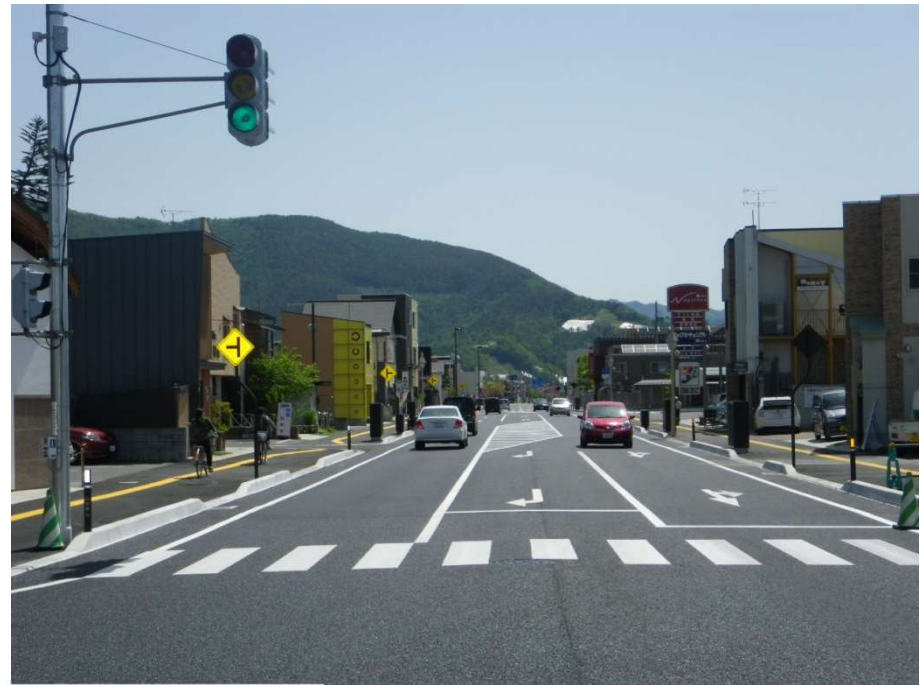
赤湯工区供用 (H25. 9)
