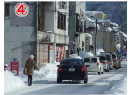
④ ○整備前の状況 (H23.1)
