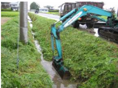
排水路の土砂上げ
