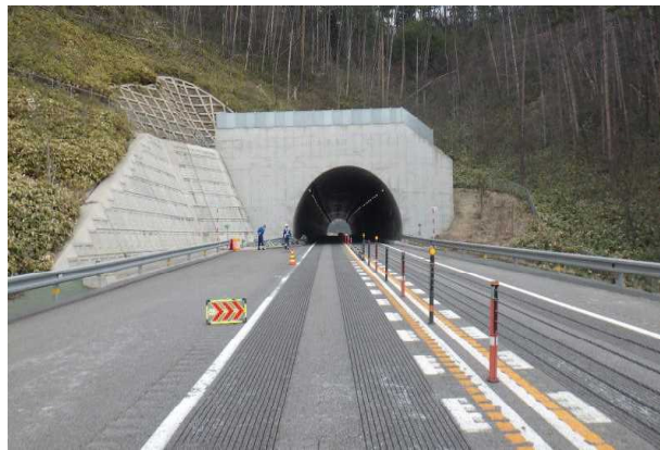
【Aの進行方向から見た現場の状況】
