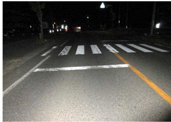
【Aの進行方向から見た現場の状況】
