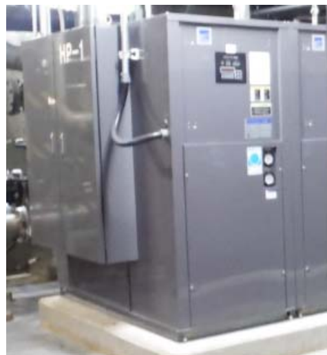
写真 1 ヒートポンプイメージ (参照：洞爺湖温泉調査写真)
