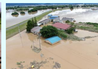
R2.7月豪雨におけるポンプ場冠水状況
