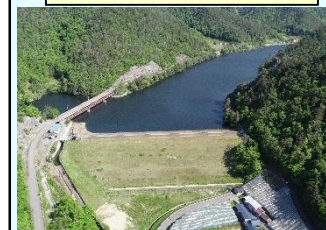
ため池の改修例
