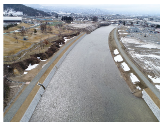
吉野川災害復旧等関連緊急事業 「三間通工区」完成 平成30年3月
