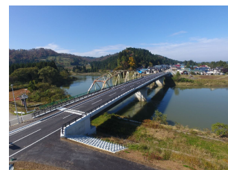
主要地方道 大石田畑線 「亀井田橋」開通 平成29年11月
