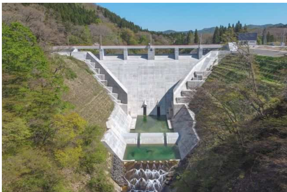
最上小国川流水型ダム（令和2年3月竣工）
