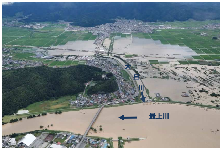
一級河川大旦川（令和2年7月浸水被害状況）
