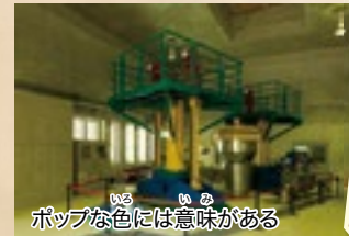
緊急時に水を排出する「放流ハルブ」。部品の色は重要度がわかるように高い方から順番に赤、黄、青、緑に色分けされています。
