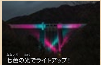
イベントのときにはダムの壁を七色の光でライトアップ。10人から申し込めるダム見学ツアーではダムの中にも潜入できます。
