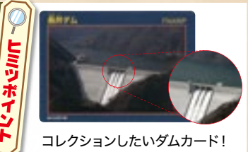
コレクションしたいダムカード! 全国のダムで配布されているダムカード。長井ダムのダムカードの写真は過去に1度だけ試験的に非常用洪水吐から水を流したときの貴重な写真。
