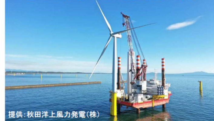
SEP船による海上施工の様子(能代港・秋田港内)
