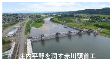
庄内平野を潤す赤川頭首工
