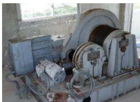
機械設備の補修
