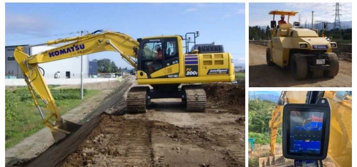
ICT活用工事の施工例 (3次元データを活用した盛土工事)
