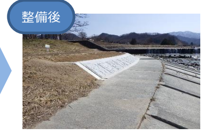
➢ 破損した護岸を修繕したことにより、治水安全度が向上した状況
