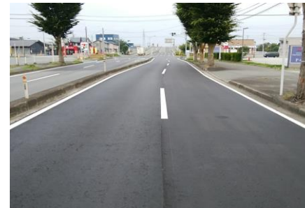
▲補修を行った舗装の例
