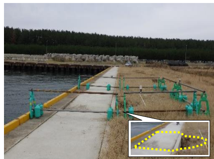
高砂取付護岸（R1年度発生）
