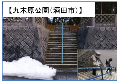
▲階段の踏み幅が狭く利用が危険な公園
