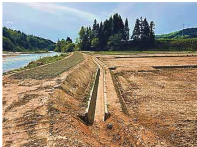
復旧後（土砂撤去）（令和7年6月）
