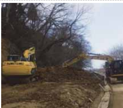
本復旧に向けた土砂撤去
