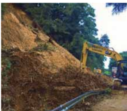
仮復旧工事中
