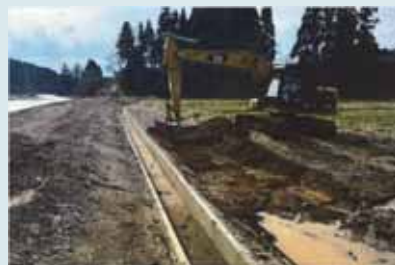
堆積土砂を撤去して農地、 水路の復旧 (国・県・町・土地改良区)
