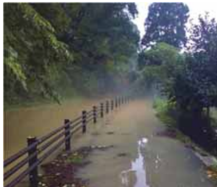
水路閉塞による越水状況
