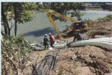
仮設ポンプを用いた営農に 必要な用水の確保 (国・県・町)
