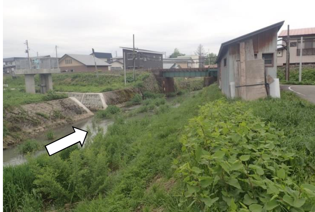
改良前状況 (NO.84付近)
