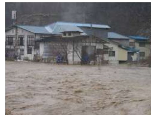
平成18年12月26～27日(低気圧と融雪) 床上浸水2戸、床下浸水6戸
