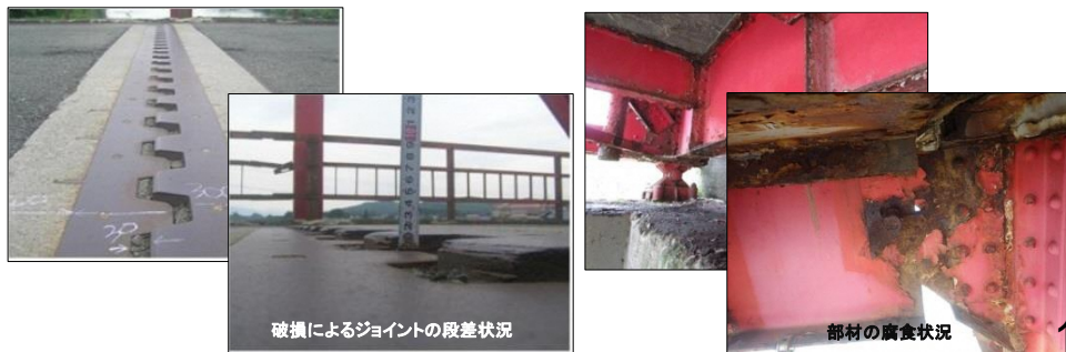
老朽化による腐食・破損状況
