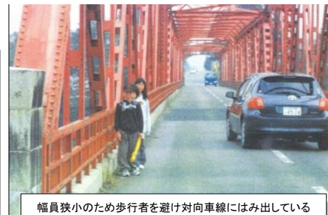
幅員狭小のため歩行者を避け対向車線にはみ出している
