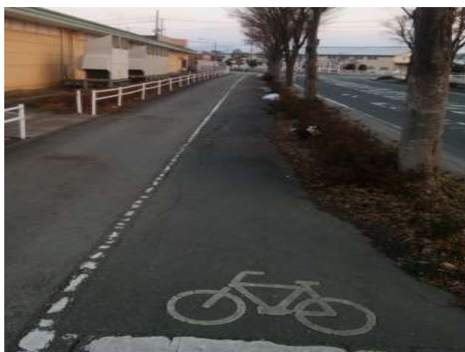
市道北江米沢線（寒河江市）
