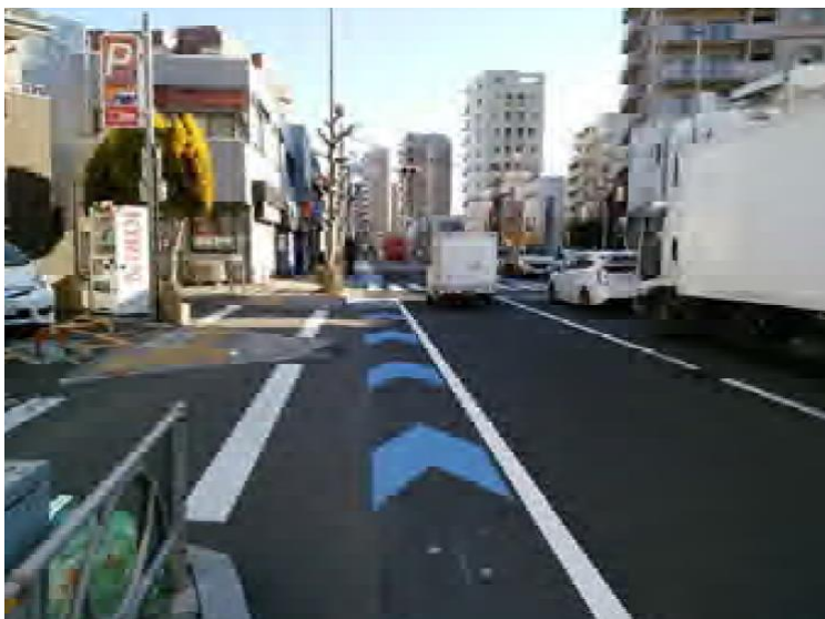
▲車道左側部の路肩内に路面標示を実施した事例 出典：安全で快適な自転車利用環境創出ガイドライン
