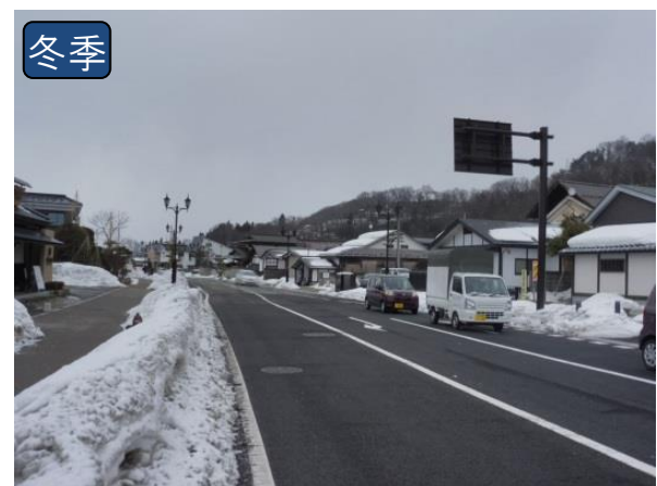
▲十分な幅員の路肩の整備事例 (主)山形天童線(天童市一日町)
