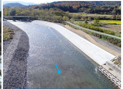
鬼面川(米沢市広幡町成島地内)護岸復旧完成
