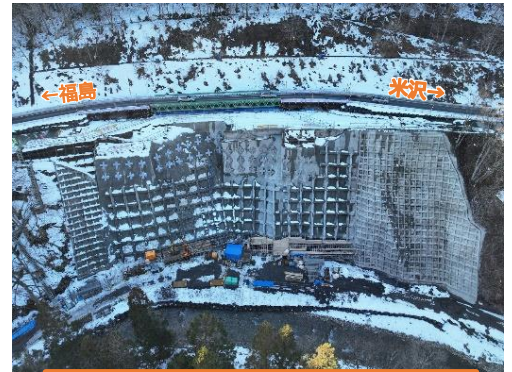
国道121号(米沢市入田沢地内)道路川側法面復旧
