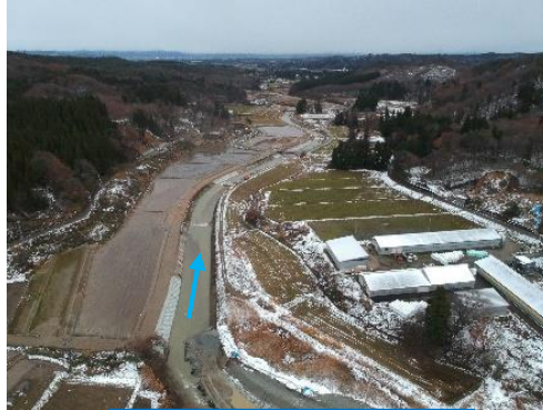
小白川(飯豊町小白川地内)護岸復旧
