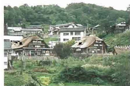
旧街道沿いにみられる民家（朝日村田委俣）
