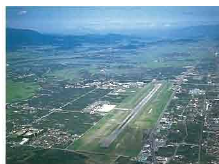
県の玄関口となる山形空港（東根市）
