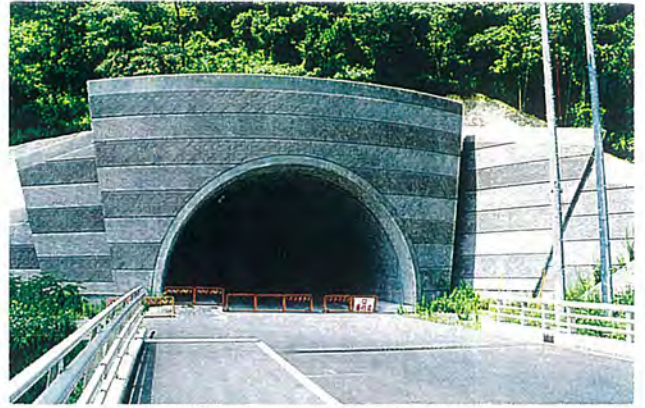
面壁と周辺の施設とが一体的にデザインされているが、手前の橋梁高欄等にもデザインの配慮が必要である。
