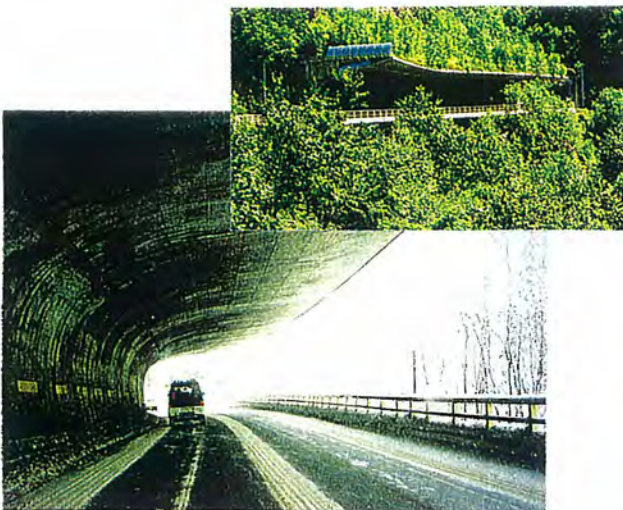
シェッドに片持ち構造を用いることにより、谷側の良好な眺めを確保している。
