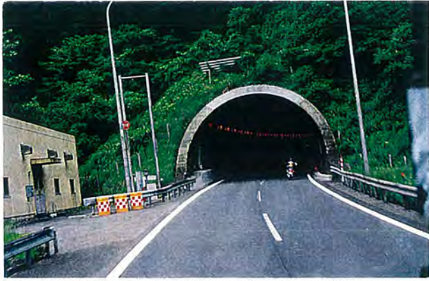
坑口部周辺に緑化を行うことにより、周辺の自然景観と調和させている。
