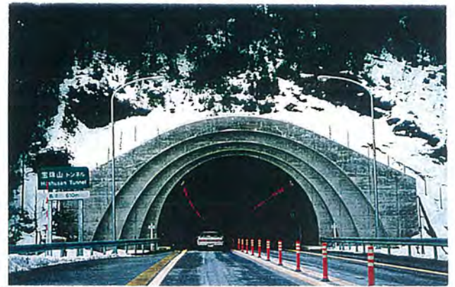
面壁を段階的に後退させることにより、坑口が広く見える効果を生み出し、進入抵抗感が緩和されている。
