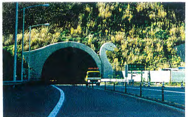
面壁の形状に地域性（白鳥）を直接的に示したために、周辺の自然環境と脈絡のない浮き立った印象となっている。
