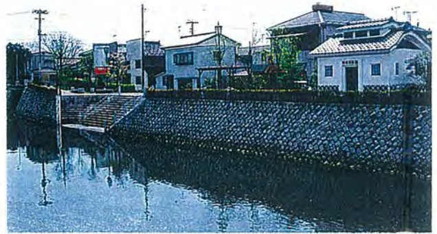
歴史的な地区の特性に配慮した石積み護岸の整備。護岸天端に生垣が植えられ、背後の建物の足元が隠されることで、河川空間と都市空間との関係が良好なものとなっている。
