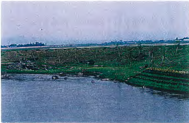
堤防の緩傾斜化を図ると同時に、植栽を行い、利用上快適な水辺を形成している。しかし、必要以上に庭園的な意匠はかえって不自然な印象を与える恐れもある。
