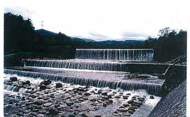
本ダム、副ダム、流路工などが自然石で統一され、一体の砂防施設として認識できる。また、自然石を用いることで、周辺の自然景観との調和がとれている。
