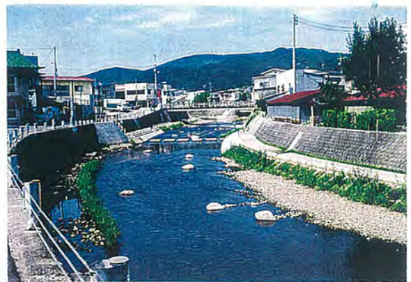
既存護岸前の水辺では、自然復元を図り、緑豊かな水辺空間を形成しようとしている。沿川での緑化の工夫等、都市と河川との良好な関係の向上が望まれる。
