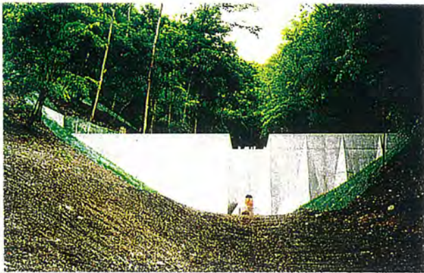
張出した支壁でダム本体を支える形態を取ることにより、構造物に見た目の安定感を与えるとともに、壁面に変化を与えている。
