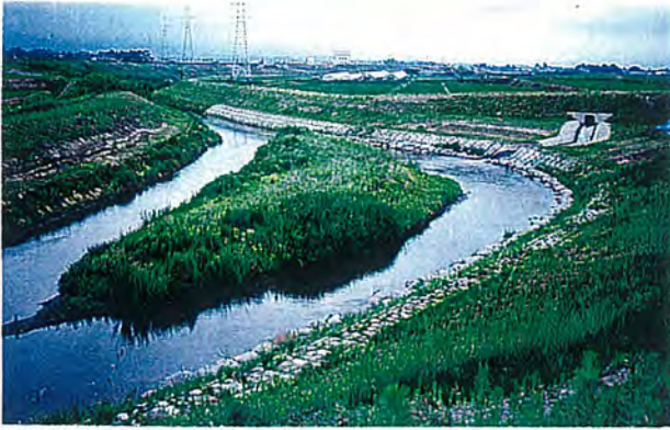
河道の屈曲に応じて、河川空間を広く取り、平面形・断面形に変化を与えて自然的印象を高めている
