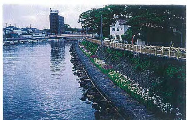
低水護岸天端にアヤメを植栽して、水辺のプロムナードとしての快適性を高めている。ただし、観光スポット以外での適用には十分な注意が必要である。
