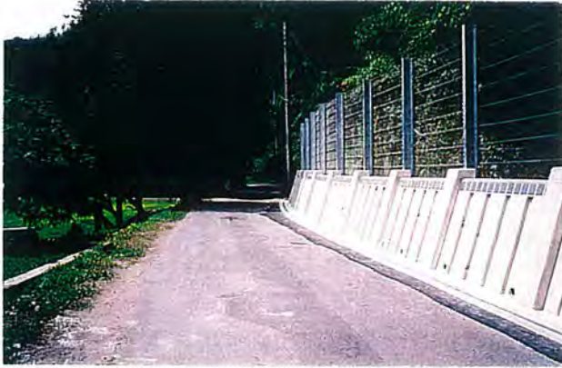
落石防止柵の支柱の位置に合わせて擁壁にリブが設けられ、施設相互の脈絡が感じられる。しかし、コンクリートのリブスリットは陰影を生み出しているが、周辺景観の中にあっては明度が高すぎる印象を受ける。 島根県津和野町
