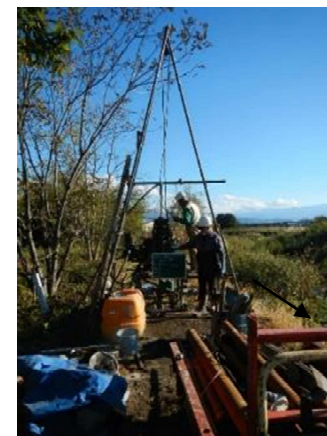
地質調査状況
