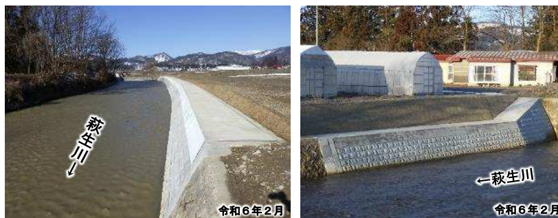
完成区間の状況
