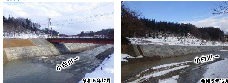
完成区間の状況
