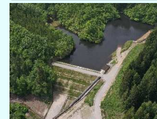
ため池の改修例
