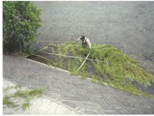
図8 完成した「竹流し」の設置
