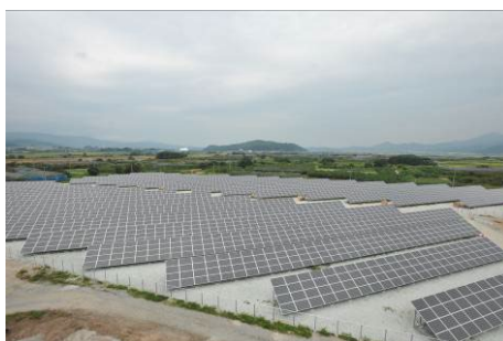
村山浄化センター
