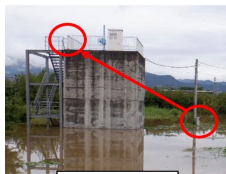
浸水のおそれのある 受電盤の移設
