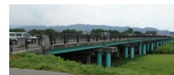
▲(一)板谷米沢停車場線(米沢市) 相生橋架替
