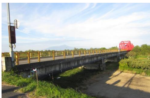
▲(主)庄内空港立川線(三川町) 両田川橋架替(調査)
