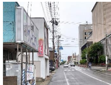
▲(国)112号(酒田市本町) 無電柱化・歩道整備
