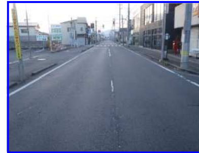
②着工前写真
