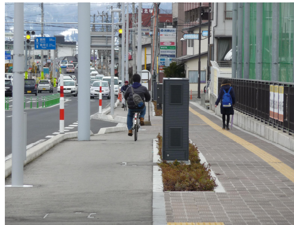
▼国道112号の植栽帯の状況
