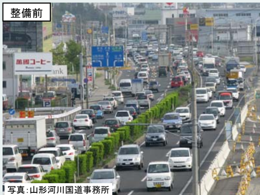
整備前 写真：山形河川国道事務所
