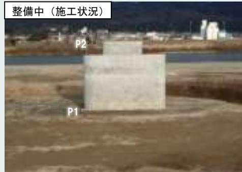
▲庄内橋の下部工の整備状況
