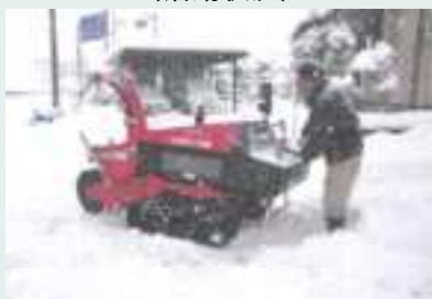
▲歩道の除雪作業
