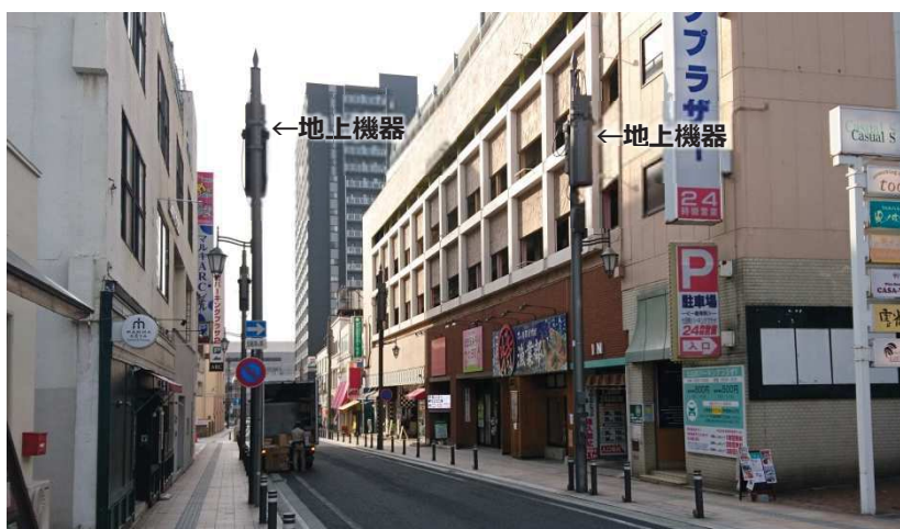
▲ソフト地中化による無電柱化の例（山形市内）
