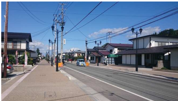
▲電線による街並み景観の阻害の例（天童市内）
