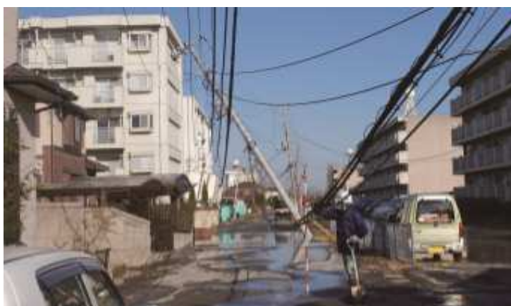
▲電線の倒壊の例（国交省ホームページより） 災害時の救助活動の妨げとなっている。
