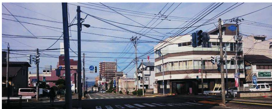
▲電線が緊急輸送道路の上空を輻輳している例（山形市内）
