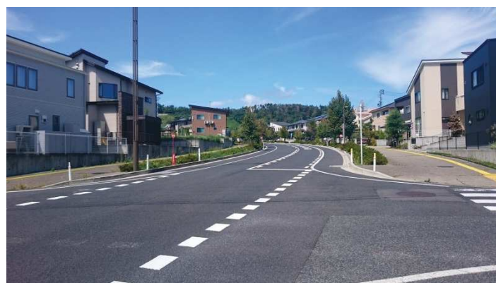
▲裏配線による無電柱化の例 (山形市 蔵王みはらしの丘)
