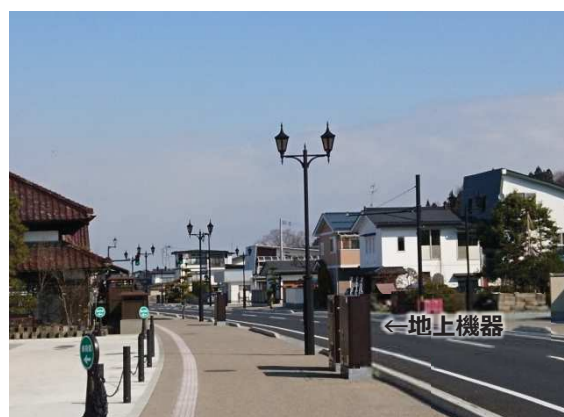
▲電線共同溝による無電柱化の例（天童市内）
