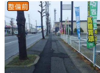
▲道路空間の再配分(植樹帯撤去)による車両走行空間・歩行空間の創出 (主)山形上山線(山形市清住町)
