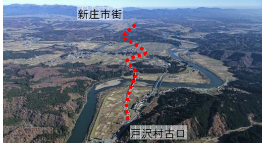
▲一般国道47号 新庄古口道路<事業中>
