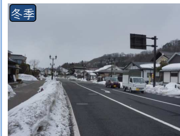
▲十分な幅員の路肩の整備事例 (主)山形天童線(天童市一日町)
