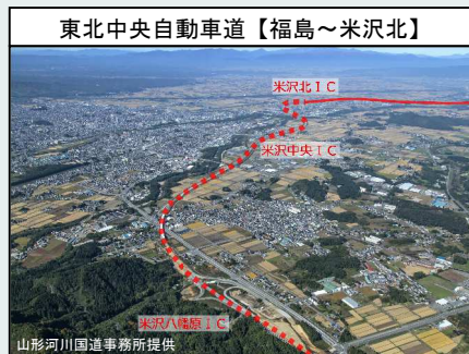
※米沢八幡原ICから北方を空撮(H28.10)
