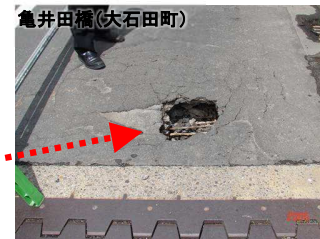
図 床版コンクリートの剥離
