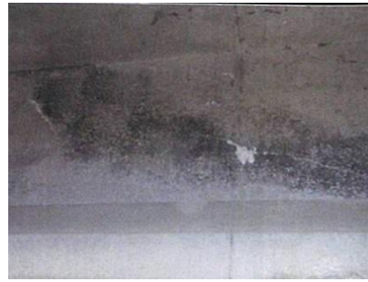
PC 桁のシースに沿ったひび割れ
