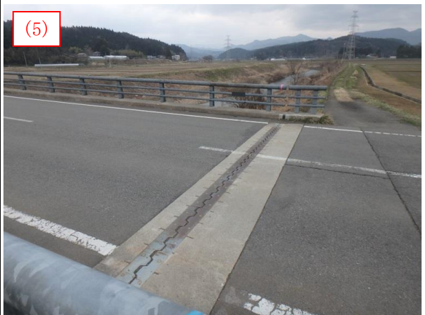
11: 伸縮装置下面(A1) 12: 伸縮装置上面(P1)
