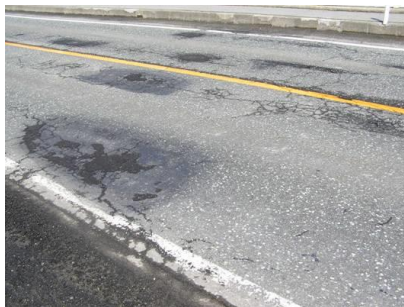
橋面と床版下面の損傷状況は関連している場合が多い
