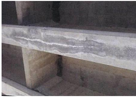
PC 桁のシースに沿ったひび割れ
