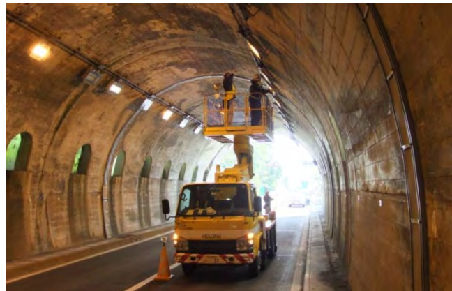
写真-解 6.1 近接目視作業状況
