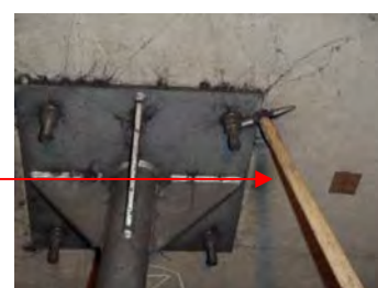
打音検査の例
