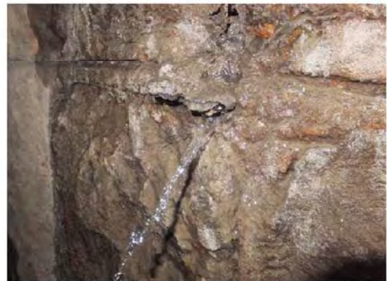
付写真-1.7 漏水（噴出）している例
