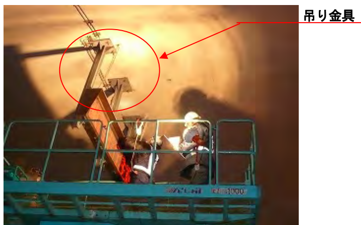
写真-解 6.3 触診作業状況
