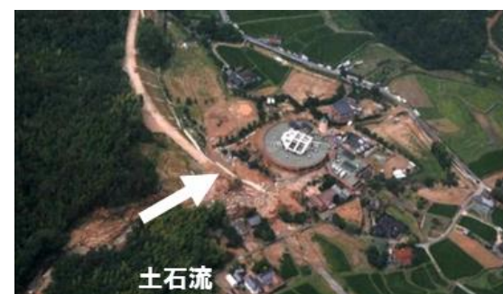
写-5 要配慮者利用施設の土砂災害
