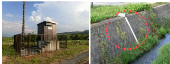
水位計の更新
