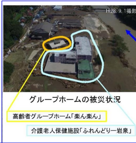
写-3 H28.8【小本川(岩手県) 浸水状況】
