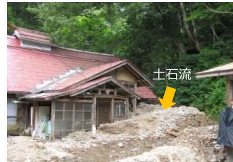
H26.7.10 発生 土石流 （下荻下沢：南陽市）
