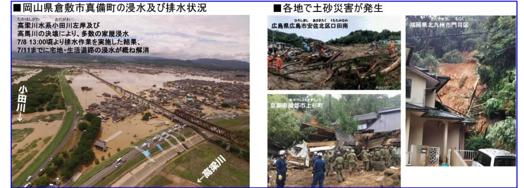
写-4 H30.7【西日本各地の浸水状況・土砂災害状況】
