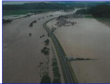
写-2 H30.8【蔵岡地区 浸水状況】
