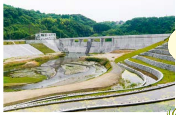
●西之谷ダム(鹿児島県鹿児島市)
