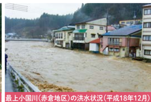
最上小国川(赤倉地区)の洪水状況(平成18年12月)
