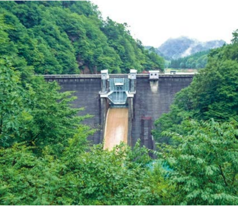
高坂ダムの洪水調節状況
