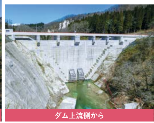
最上小国川流水型ダム完成写真
