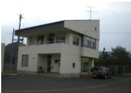
▲ダム管理所外観
