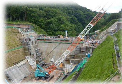
堤体工事の状況
