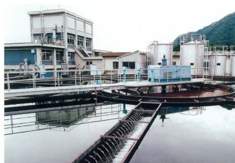
上水道（松原浄水場）
