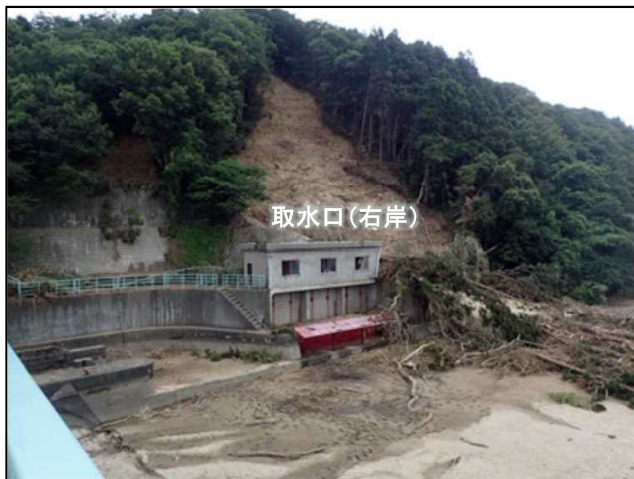
【荒川頭首工取水口(右岸)】
