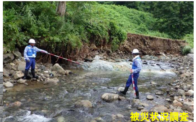
森残川 被災状況調査
