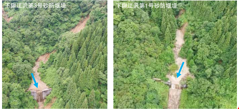
土石流発生直後 (R4.8.15)
