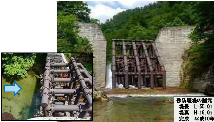
土石流発生前 (R3.6.3)
