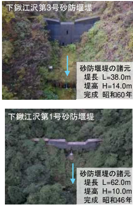
土石流発生前 (R2.10)
