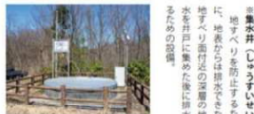
▲下沢の目地区の集水井
