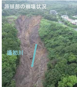
【土石流による被害状況等】
