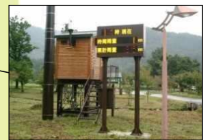
荒川流路工に隣接して整備されているオーキャンパ場等の観光施設内に雨量情報表示盤を設置
