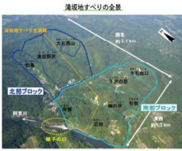
(提供:阿賀野川河川事務所)
