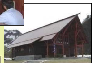
地域住民、観光客等の交流施設(マタギの郷交流館)において、雨量・CCTV映像のリアルタイム情報を提供
