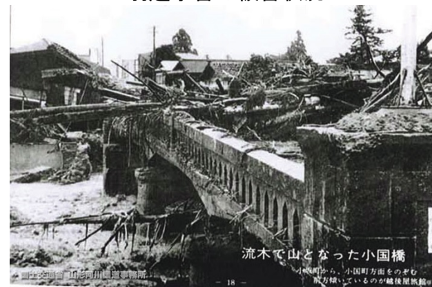
羽越水害の被害状況
