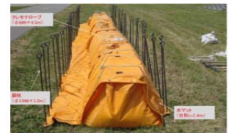
水マット工法
